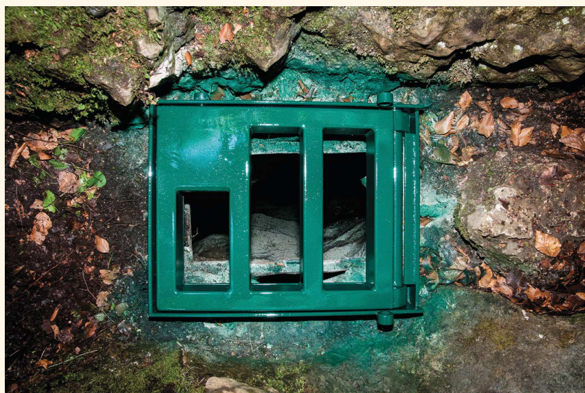
Gotowa krata w jaskini Jama Ani. Szyb wejściowy jest pionowy, więc dla wlatujących nietoperzy szczelne kraty są poziome. Na zdjęciu widok z góry.
